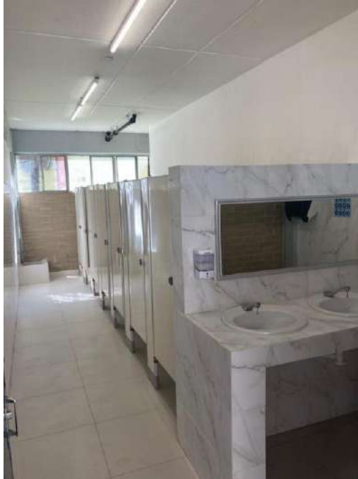
Imagen 2. Remodelación de baños edificio Z.
