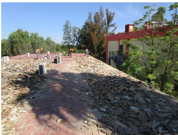
Foto 3. Inicio de trabajos de reparación de azoteas e impermeabilización
