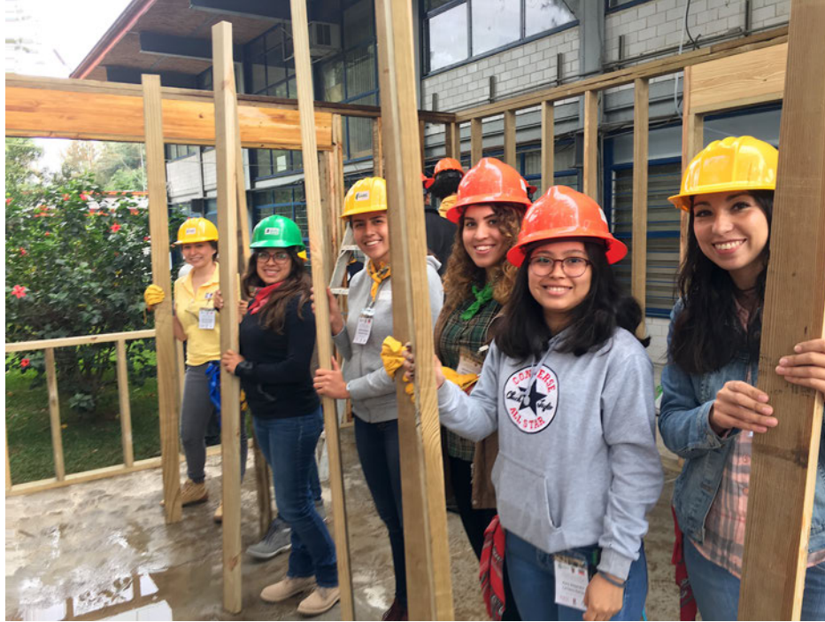
Fotografía 1. Taller de construcción con madera
