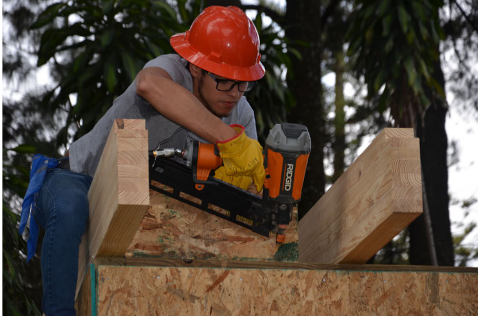
Fotografía 5. Taller de construcción con madera
