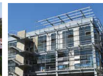
Obra en proceso de Laboratorios áreas de química
