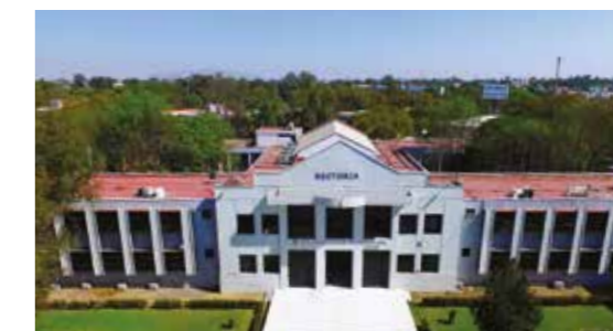
Frontispicio de la rectoría y edificio del Módulo A
