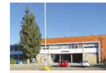
Edificio del Módulo O
